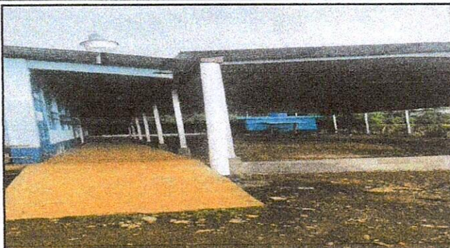
Foto1: Canales de aguas pluviales.
