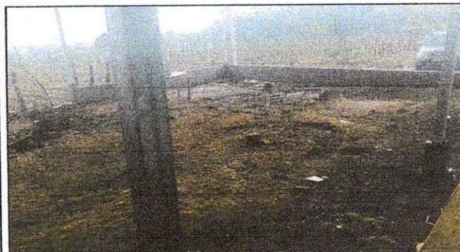
Foto 3: Muro perimetral de block.
